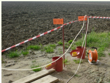
Piezometri per il monitoraggio delle acque sotterranee
