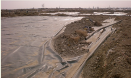
Impermeabilizzazione superficie discarica
