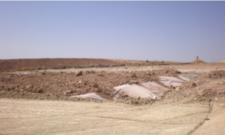
Stato avanzamento sistemazione copertura discarica
