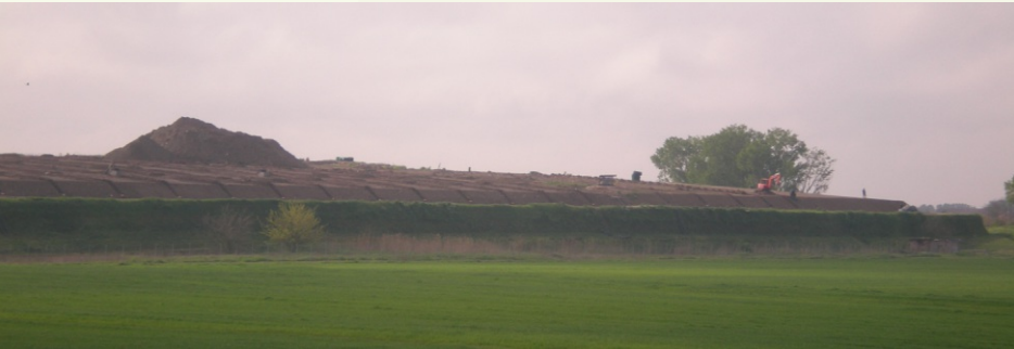
Panoramica lato monte discarica
