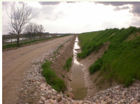
Argine di contenimento laterale A sinistra Fiume Brenta e a destra acque meteoriche di ruscellamento acque periodicamente controllate
